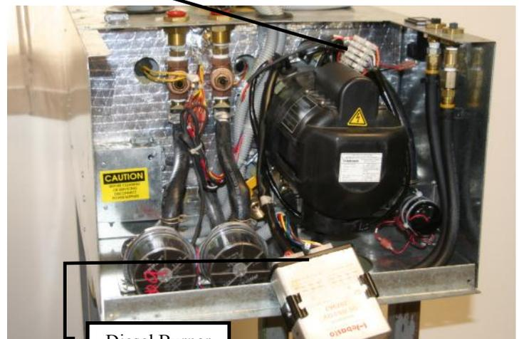
**Diesel Burner Controller Plugs**
